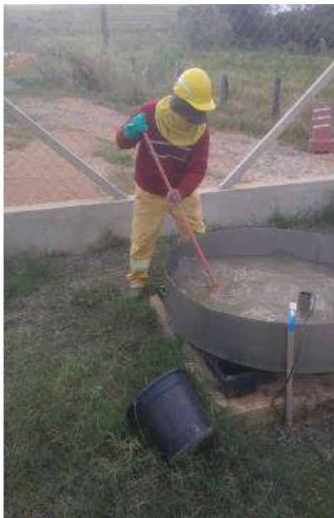
Foto 5 – Colaborador realizando a Limpeza do reservatório de água da EMA. (Data: 19/08/2022).
